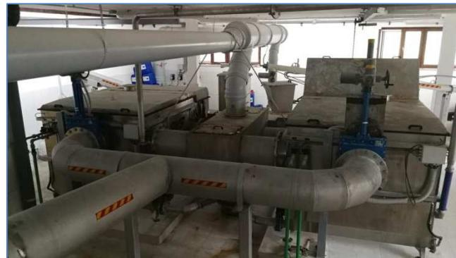
Dovod vode na 2 mikrofiltera
