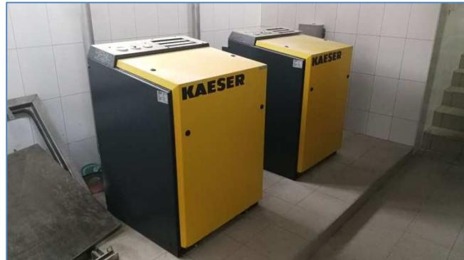
Kompresori za čišćenje mikrosita u mikrofilterima
